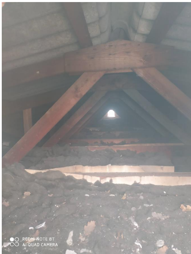
Vnitřní pohled střešní konstrukce – dřevěný sbíjený příhradový vazník
