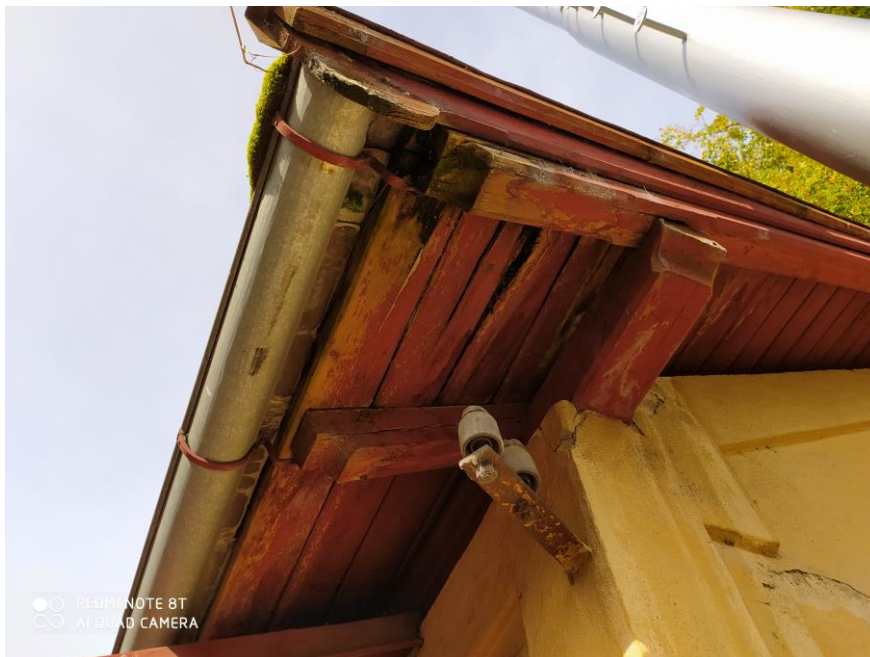
Zjištění – vyhnílé prkenné podbití
